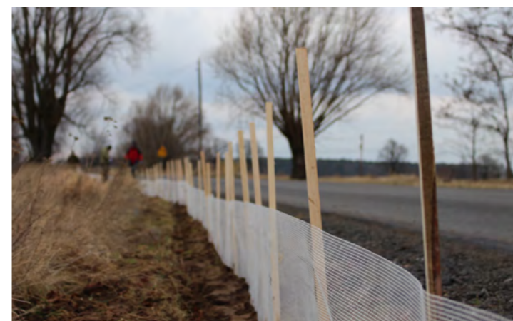
Tymczasowy płotek zatrzymują płazy przed wejściem na drogę. Fot. S. Fritzkowski
